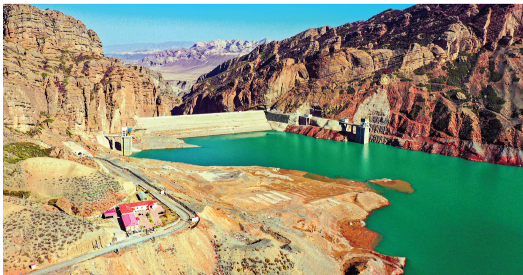
10月22日,蓝天碧水下的呼图壁县石门水库运行平稳。眼下,正值呼图壁县石门水库蓄水期,为提升灌溉和发电能力,水电站及时组织人手,不断加强水库巡查力度,及时排查安全隐患,保障下游人民群众生命安全和财产安全。 陶维明 摄
