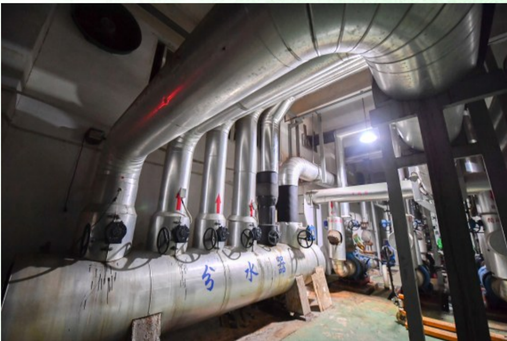
这是为湖南省湘潭市“市民之家”提供空调的水源热泵中央空调系统。
