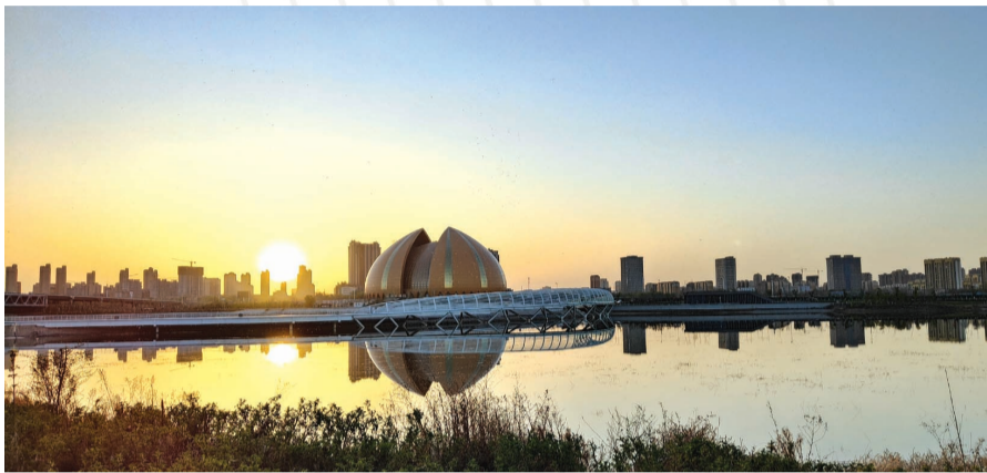
农发行昌吉州分行营业部信贷支持的头屯河沿岸综合整治工程。
