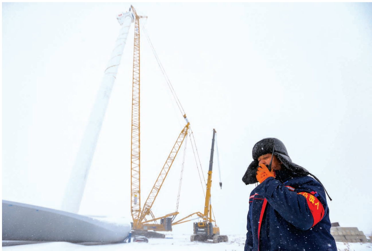
12月18日,木垒县四十个井子昌吉国投庭州能源公司10万千瓦风电项目施工现场,施工人员冒着风雪进行风机吊装作业。 该项目总投资4.65亿元,总装机量100兆瓦,项目年底建成并网发电后,预计年节约标准煤18万吨、减少二氧化碳排放54万吨,有效优化当地能源结构。 本报记者 何龙 摄
