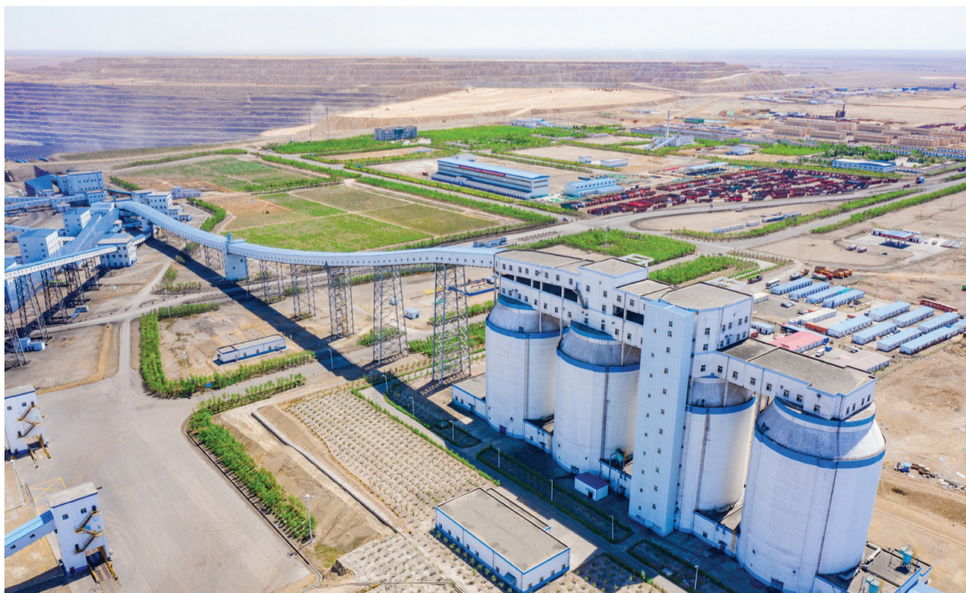
5月20日,特变电工天池能源公司南露天煤矿的全疆首套直装式筛分楼和室内分流站正在运行中。
