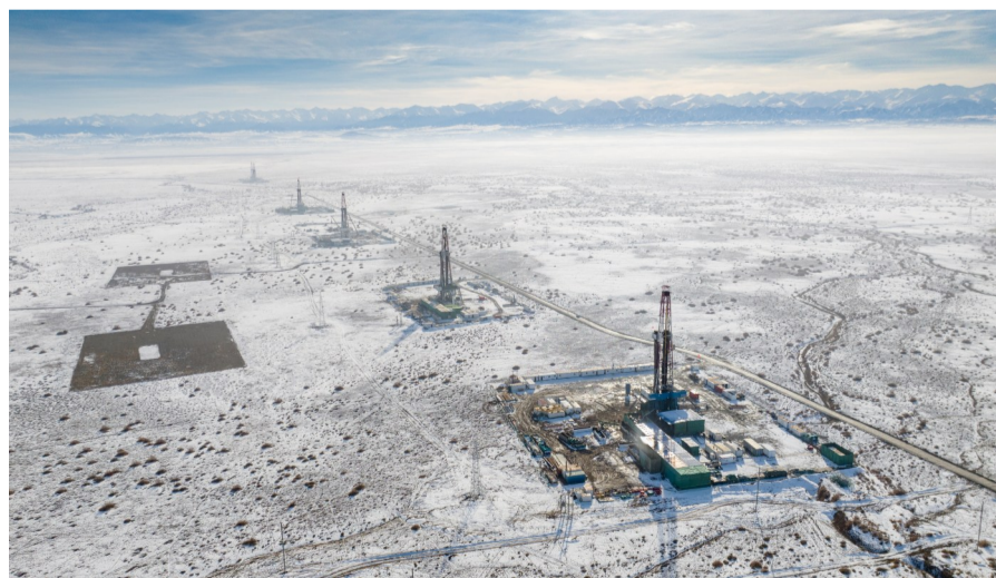
图为中国石油新疆油田分公司吉庆油田作业区页岩油井区钻井现场。张昀 摄
