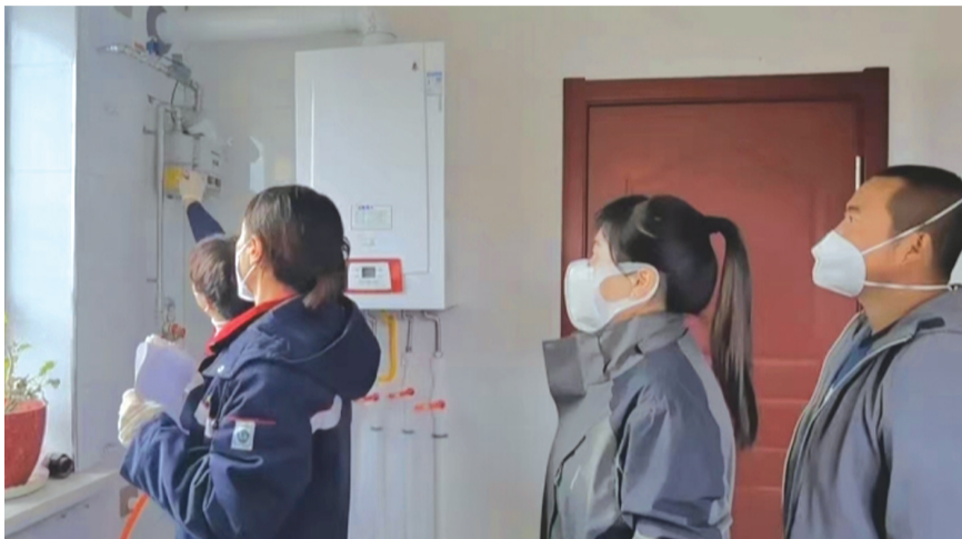
在昌吉市二六工镇十二份村,燃气安装工作人员给村民讲解天然气使用注意事项。 昌吉市零距离供图
