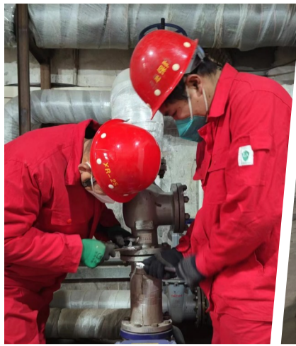
技术人员在维护供热管网,保障用户温暖过冬。
