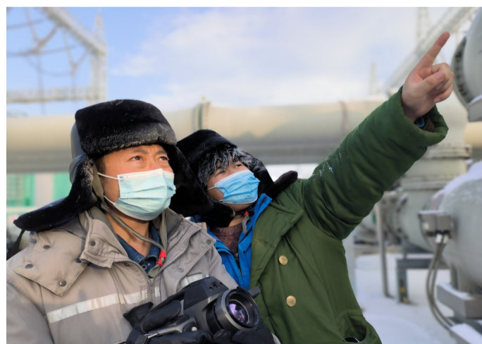
1月15日,国网新疆超高压分公司昌吉换流站的工作人员在站内进行SF6检漏测试。
