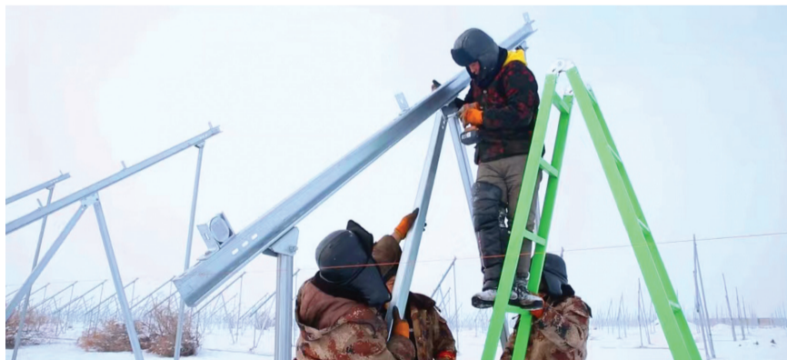
2月1日,该项目建设现场,工人正在安装调试太阳能板支架。
