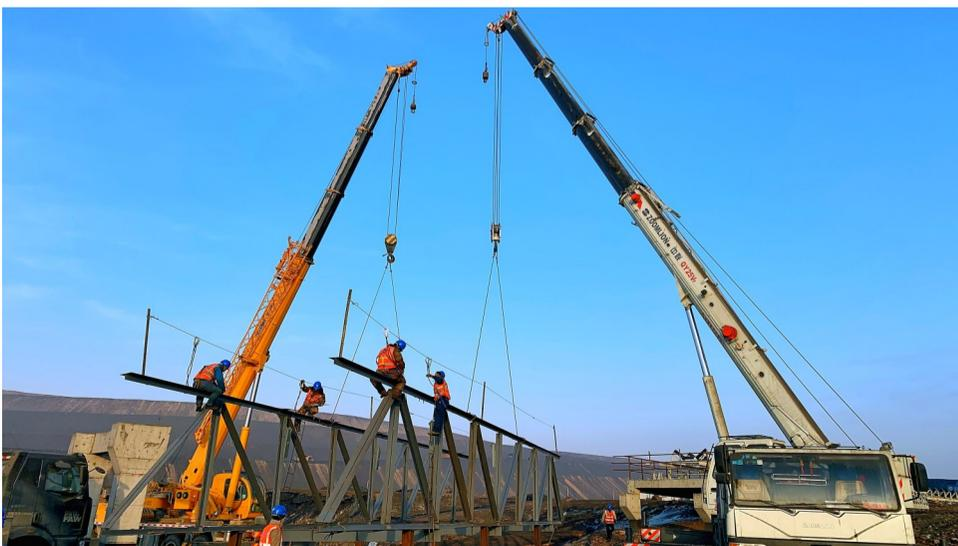
3月5日,准东开发区中煤建安集团新疆分公司承建的国能新疆准东能源有限责任公司地面原煤转运胶带机运输系统EPC项目现场,施工人员正在进行栈桥吊装。自项目开工建设以来,项目部严把项目安全生产和质量管理工作,将建设“精品工程”理念贯穿始终。
