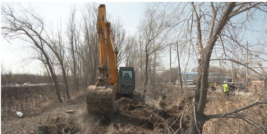
3月28日,在昌吉市滨湖镇东沟村,2023年自治区重点水利工程昌吉市三屯河“十四五”大型灌区新建配套与现代化改造工程二期项目建设现场,挖掘机正在开挖渠道。成石麟 摄
