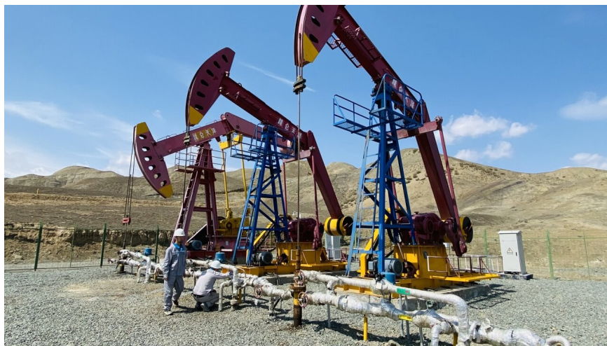
5月22日,吉木萨尔县水溪沟矿区煤层气开采现场,抽油机正在抽煤层气。
