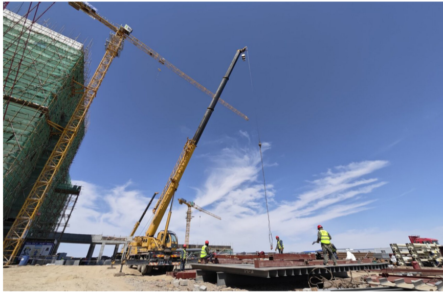
5月30日,昌吉市生活垃圾焚烧发电项目建设现场,工人们正在大型吊装设备下施工作业。 本报记者 常谊 摄
