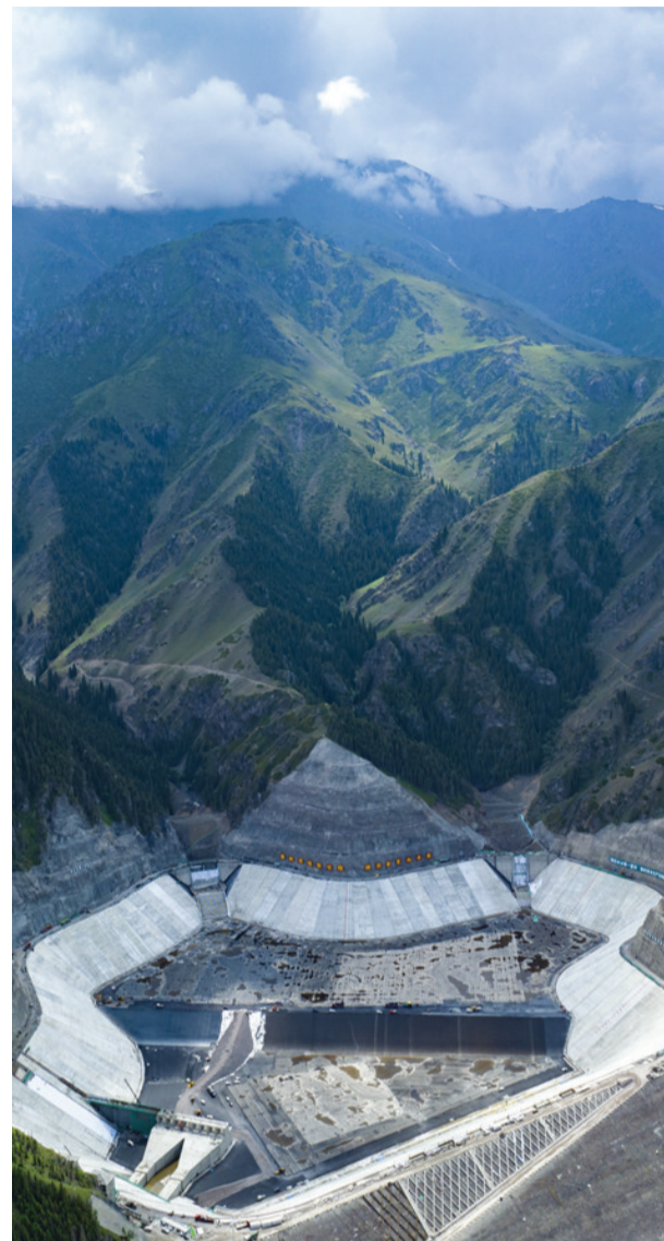
俯瞰阜康抽水蓄能电站上水库工程建设现场。
