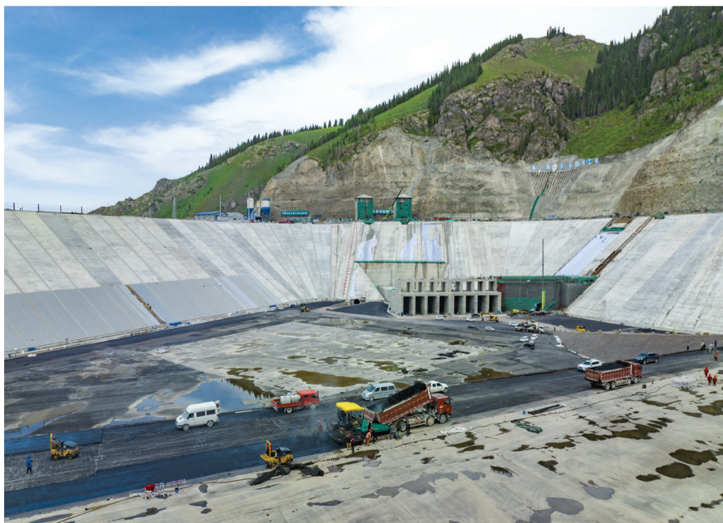
阜康抽水蓄能电站上水库工程库底沥青混凝土面板施工现场。
