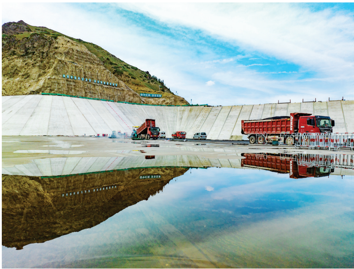
左图:阜康抽水蓄能电站上水库工程正在施工。
