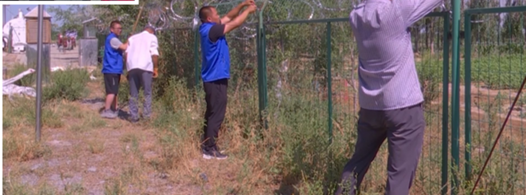
右图:凉州户镇组织人员在全镇危险水域周边安装防爬网,加固护栏,树立警示牌,全方位确保群众生命安全。
