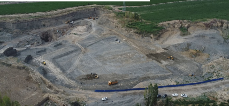
7月10日,垃圾填埋场项目施工现场各类大型机械有条不紊施工中。 张海洋 摄
