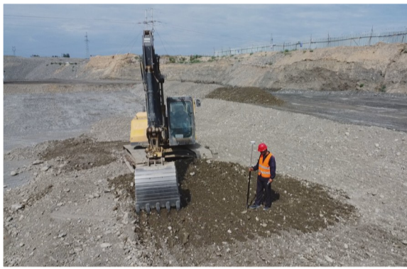
左图:7月10日,垃圾填埋场项目施工现场,挖掘机在加紧工作。
