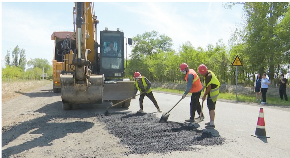
在X156玛南公路养护施工现场,沥青运输车和沥青摊铺机缓慢前进铺设沥青,压路机紧随其后进行压实作业,确保高质量完成路面修复养护。再努尔·艾克拜尔 摄
