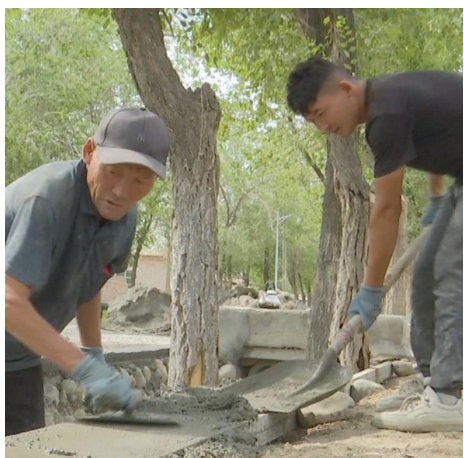
在乐土驿镇白杨树庄村,村民投工投劳,修建水渠,现场一派热火朝天的劳动景象。再努尔·艾克拜尔 摄
