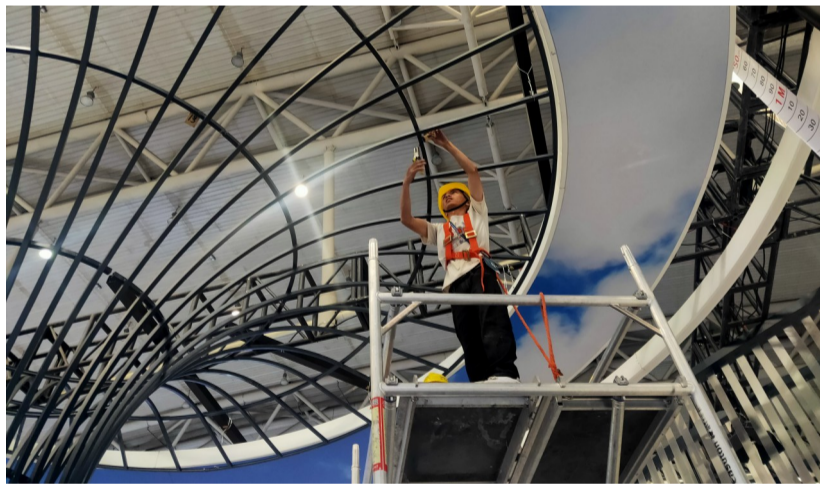
8月14日,在新疆国际会展中心6号展馆内的昌吉州形象展厅,施工人员正在加固不锈钢金属管。 本报记者 刘辉 摄
