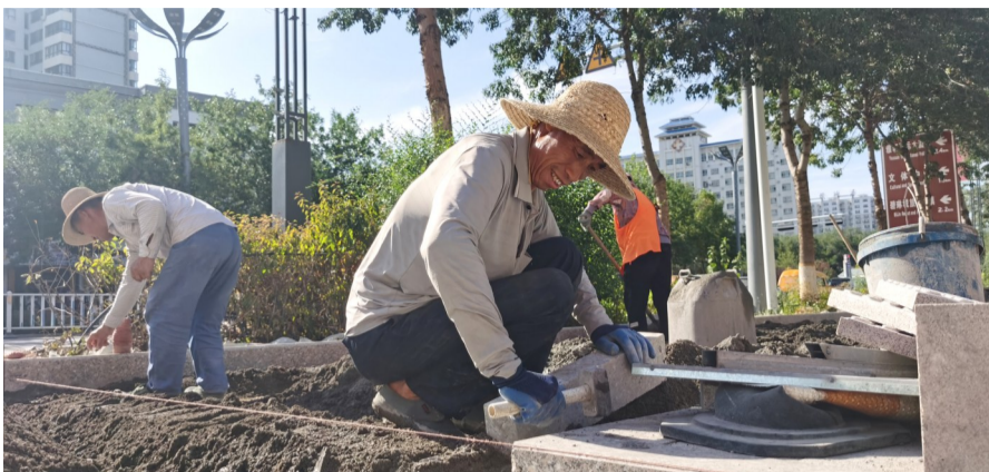
施工人员正在对阜康市迎宾路与博峰西路交会处人行道路面的老旧破损彩砖进行重新铺装。 刘媛 摄
