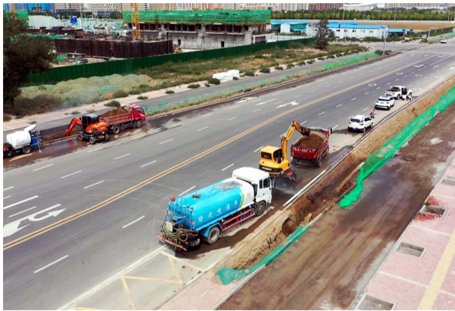
近日,在昌吉市中山路(石河子路至哈密路路段),大型机械正在开挖管沟,为路灯和标识标牌安装做好准备工作。 刘华 摄
