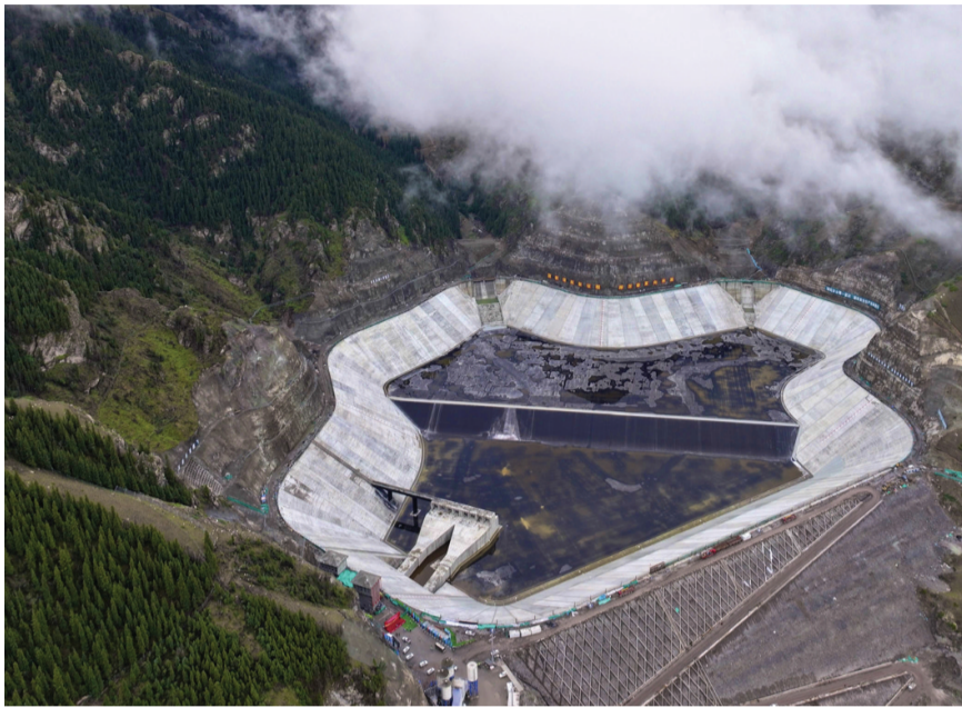
国网新疆阜康抽水蓄能电站上水库全貌。
