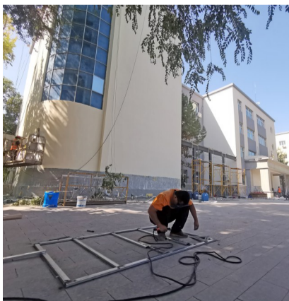
在昌吉市第一中学,工人正在焊接门窗。 刘华 摄
