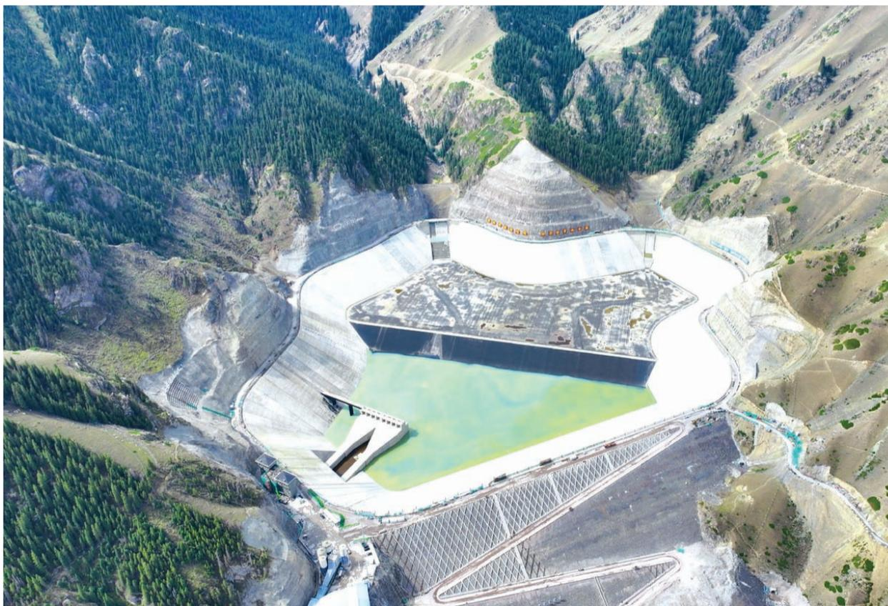
近日,国网新疆阜康抽水蓄能电站已完成上、下库蓄水等年度建设目标,9月将启动1号机组整组调试工作。国网新疆阜康抽水蓄能电站上水库大坝为混凝土面板堆石坝,坝顶高程2275米,最大坝高133米,坝顶长度431米,总库容845万立方米。图为国网新疆阜康抽水蓄能电站上水库全景。 耿文浩 摄
