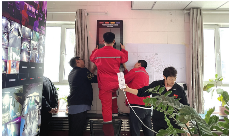
8月29日,昌吉州地震局工作人员在呼图壁县小甘沟煤矿现场安装地震预警信息发布终端。 刘萍丽 摄
