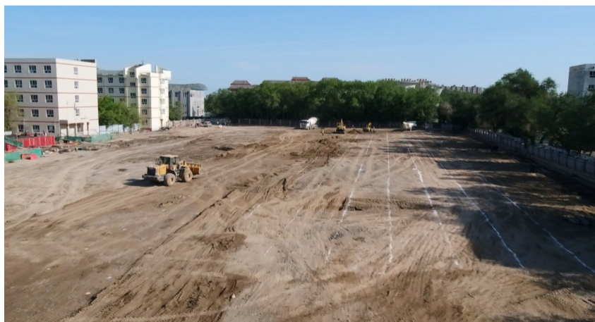
近日,在玛纳斯县第一中学操场上,大型机械在进行施工作业。
