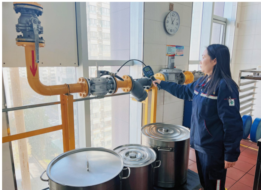
11月1日,新疆东方环宇燃气股份有限公司工作人员在昌吉市凯森酒店后厨,利用便携式手持燃气检测仪进行燃气安全检测。 本报记者 田晶 摄
