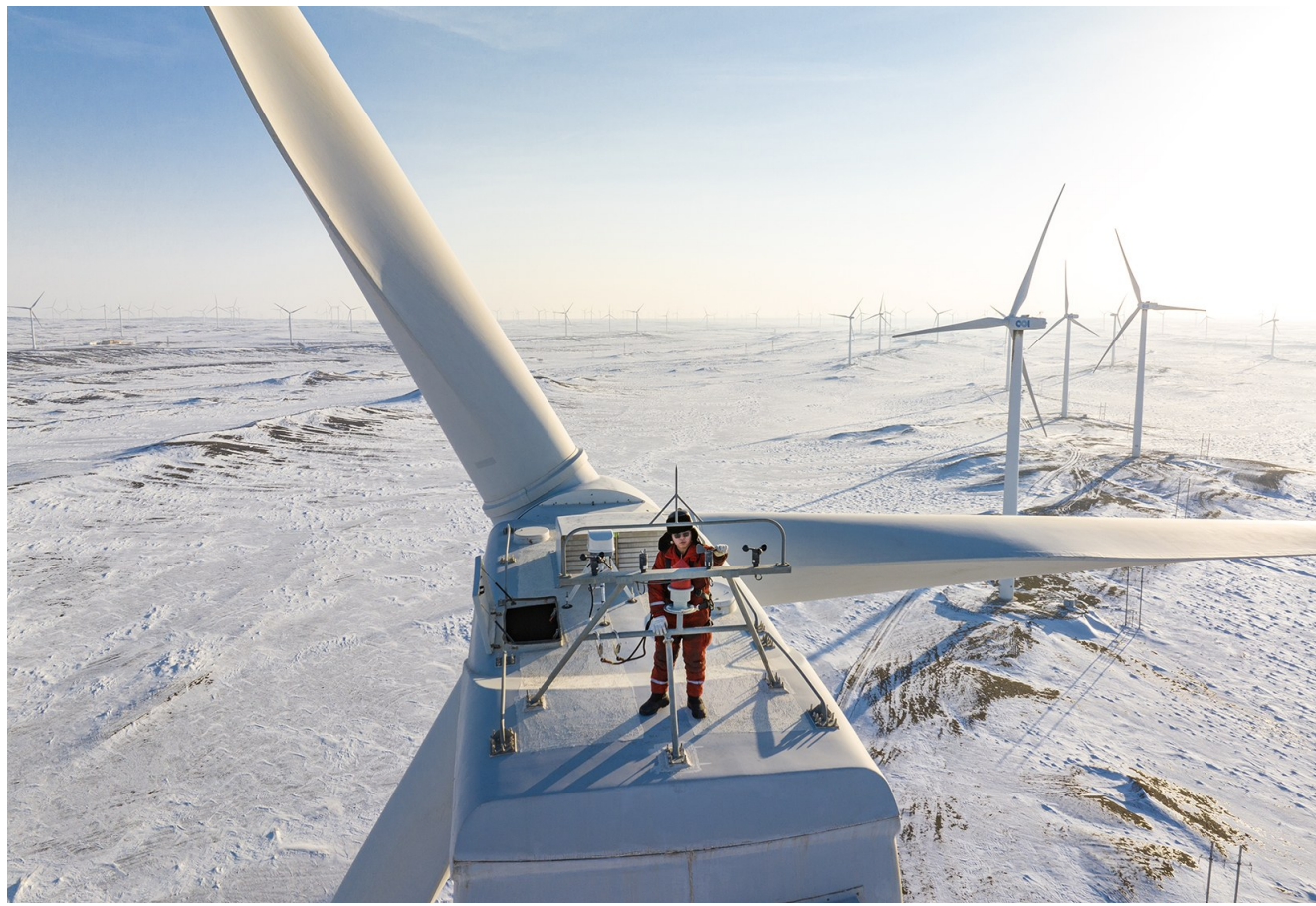
1月21日,木垒老君庙风电场,国家电投集团新疆能源化工木垒新能源有限公司检修人员在100多米高的风机顶端查看风向标等部件状态。
