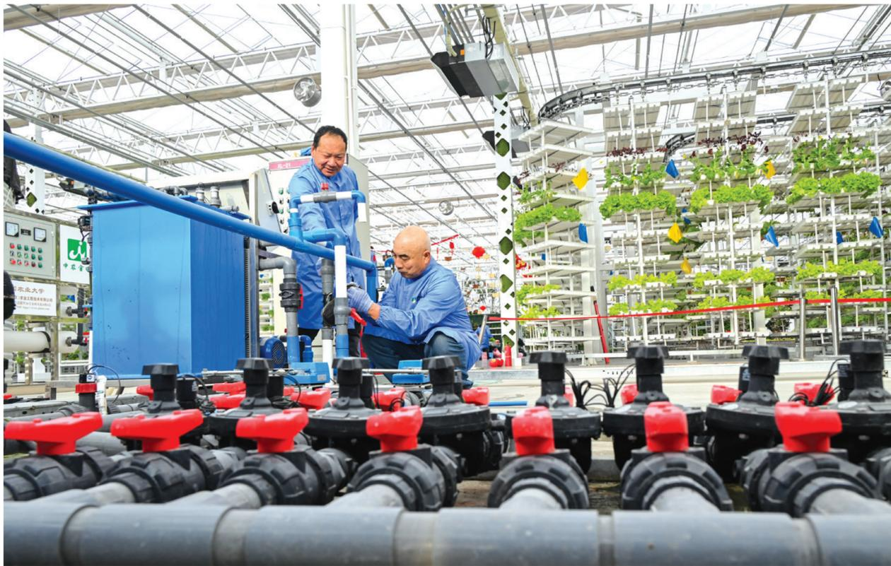
2月6日,工人在昌吉国家农业高新技术产业示范区新疆农业博览园内的未来农业科技馆对蔬菜供水设施进行维护。未来农业科技馆由垂直农业展示区、叶菜工厂示范区和果菜工厂示范区三部分组成,于2022年建成投用。该馆集成使用多项先进技术,将物联网环境自动控制与精准水肥一体化灌溉等农业种植技术相结合,不仅节约了用水,还节省了人力,实现了蔬菜种植的高度自动化。
