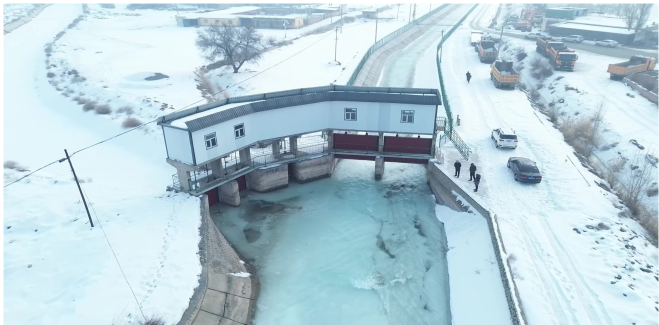
2月27日,玛纳斯河第二总分水闸配水点开闸放水。
